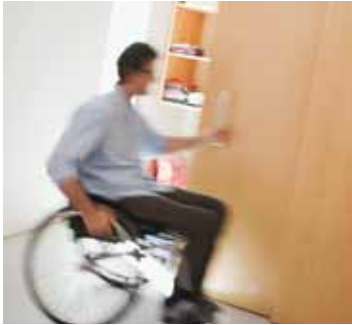
Vertikale Bügelgriffe eignen sich am besten zum Öffnen von Schiebetüren.
